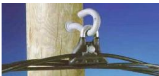
شکل ۴- نحوه نصب کابل باندل هوایی به پایه
