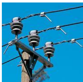
شکل ۱۰- نمونه ای از تجهیزات انحراف ساز قوس
